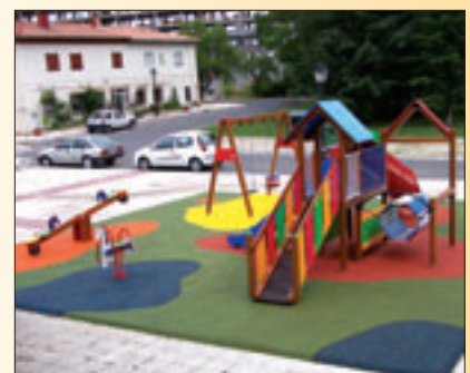
INSTALACIÓN PAVIMENTO CONTINUO
